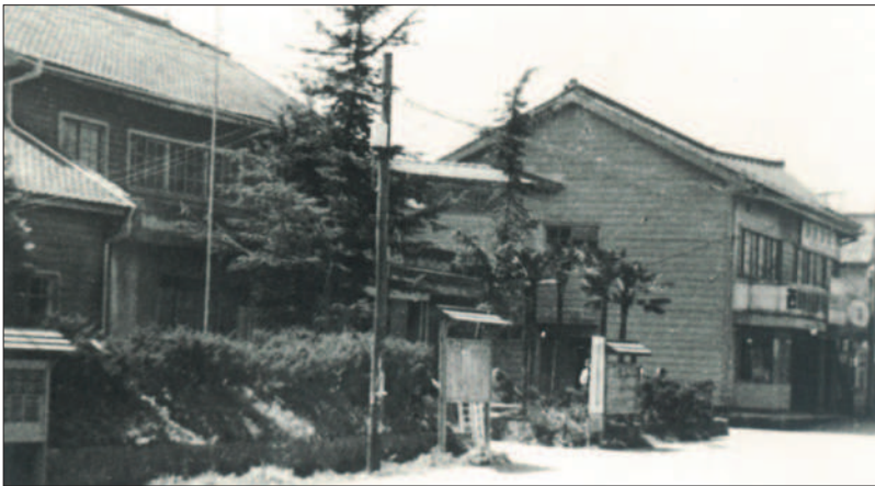
商工会議所(左)と西宝商工会館(右) (昭和21年度) 昭和初年、国府にあった郡役所を竹本油脂が払い下げを受け、しばらくは、会社の福祉施設として利用していた。その後町商工会(商工会議所の前身)へ寄付され、商工会議所事務所として使われ、戦後21年商工会議所発足と同時に商工会議所となった。
