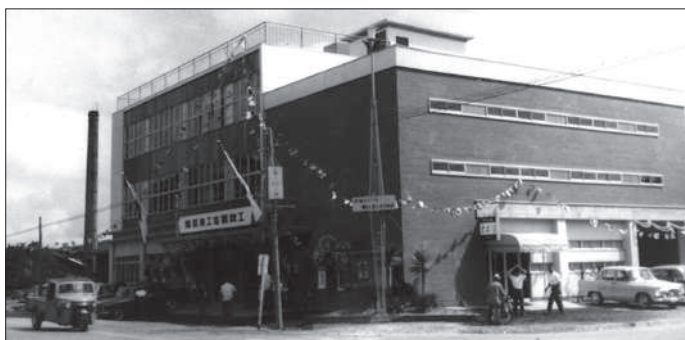
旧商工会館全景（昭和37年度）
