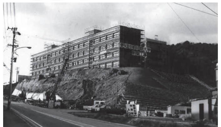
工事中の愛知技術短期大学 (昭和61年度)
